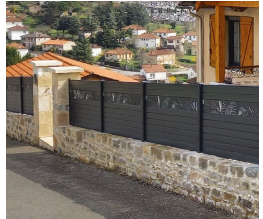
pose en pente
